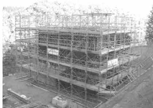
※型枠・鉄筋・足場工請負工事も出来ます。
